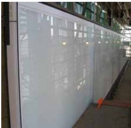
第三層：新幕牆安裝作業平台（圖片來源：B+H）
