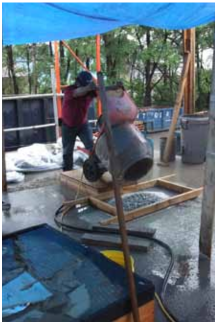
左上圖：老舊瓷磚浸泡在水中，方便之後將其從基層上剝離；右上圖：浸泡後的瓷磚塊放入轉鼓，實現剝離；下圖，從左至右：轉鼓內的瓷磚；將清潔打磨後的瓷磚與新的瓷磚混合在一起後（補償損失部分），放入袋中；剝離干淨後的瓷磚從轉鼓中倒出，放置在篩網上
