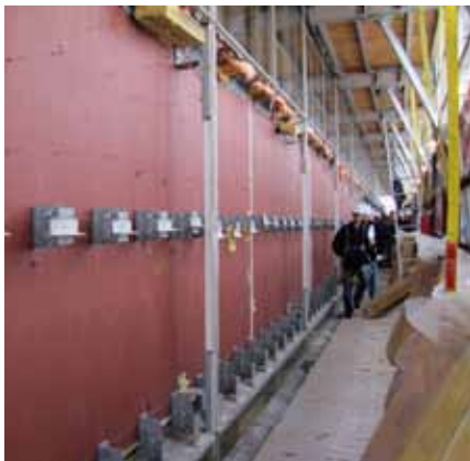
第一層：石材拆除與修補作業平台（圖片來源：B+H）
