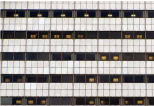
加拿大第一廣場翻新前表層立面放大圖（圖片來源：B+H）
